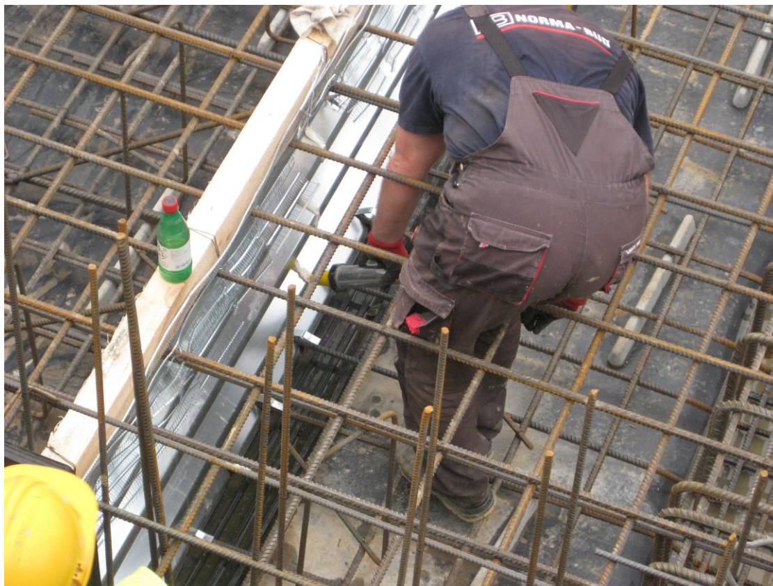
Fot. 25 Uszczelnienie przerwy roboczej w płycie fundamentowej
