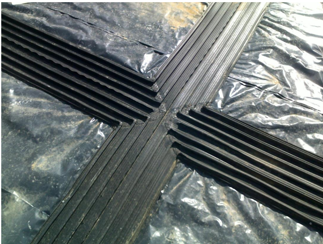
Fot. 11 Zewnętrzna taśma uszczelniająca PVC do przerw roboczych
