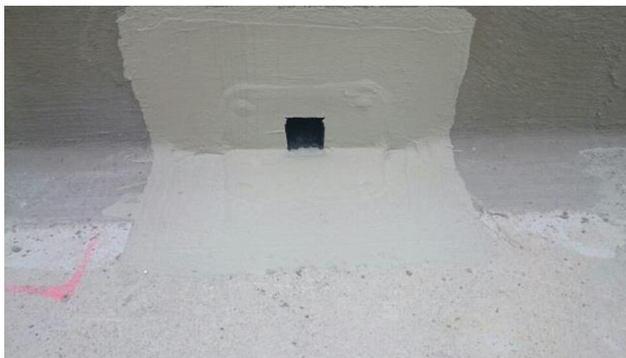
Fot. 22 Uszczelnienie rzygacza (rynny) w stropodachu za pomocą żywicy triflex prodetil
