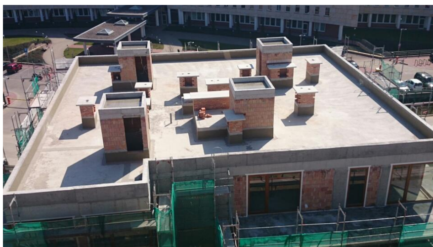
Fot. 21 Uszczelnienie stropodachu w technologii hydroizolacji bezpowłokowej
