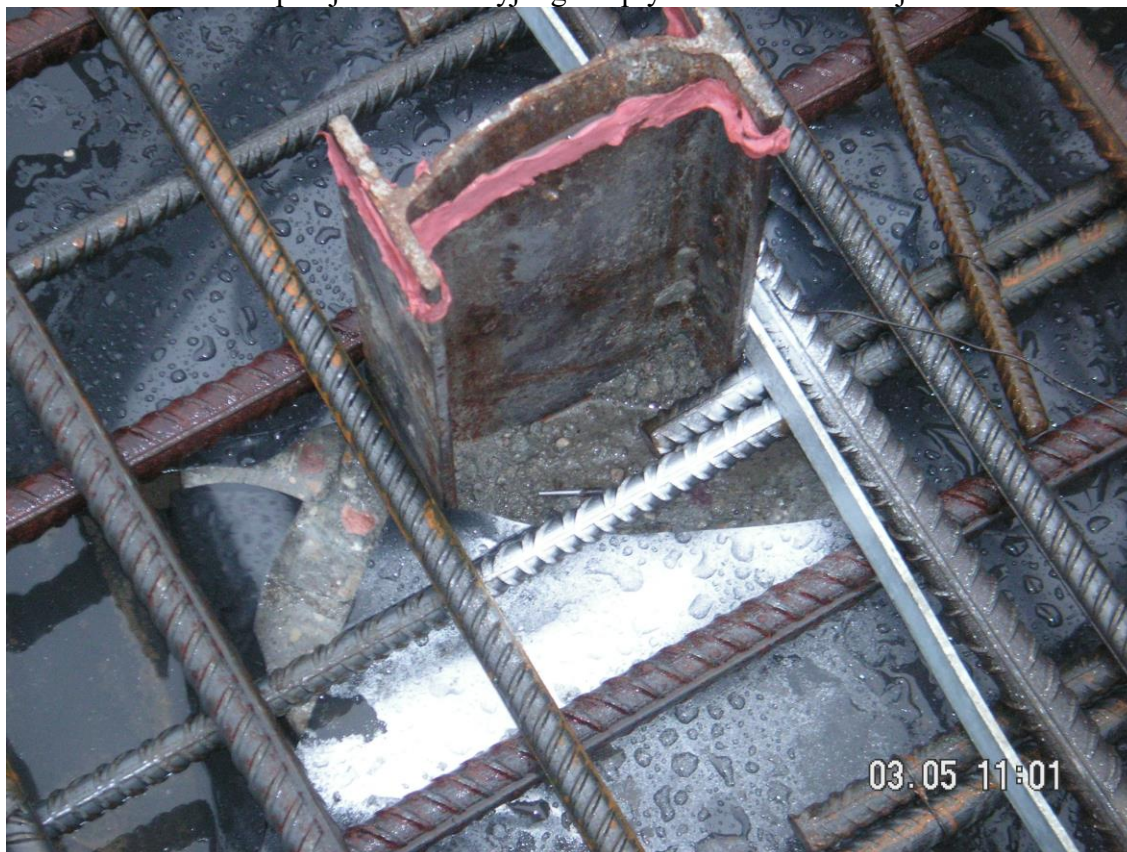
Fot. 5 Uszczelnienie zbrojenia pała wchodzącego w płytę fundamentową
