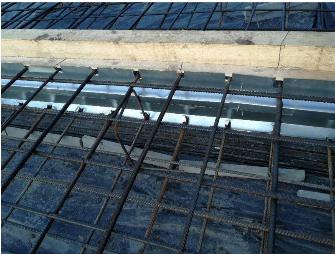
Fot. 24 Uszczelnienie przerwy roboczej/skurczowej w płycie fundamentowej
