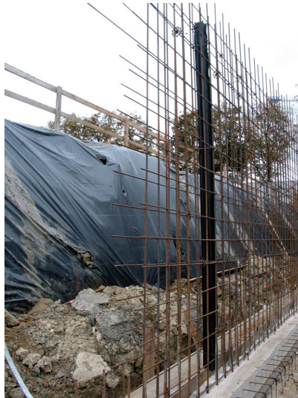
Fot. 10 Profil rysujący –uszczelniający Q88 w zewnętrznej ścianie fundamentowej
