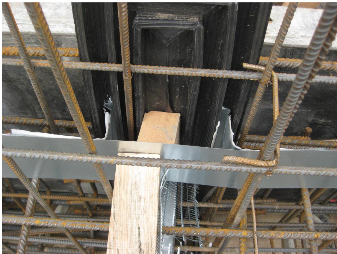
Fot. 26 Zakończenie przerwy roboczej płyty fundamentowej
