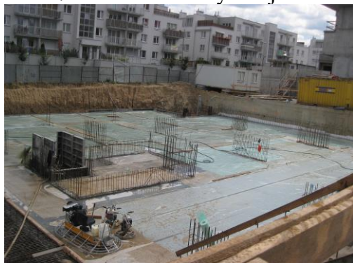
Fot. 28 Pielęgnacja płyty fundamentowej
