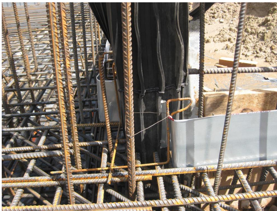
Fot. 27 Uszczelnienie dylatacji konstrukcyjnej [zewn. taśma kątowna] w zewn. ścianie fund.
