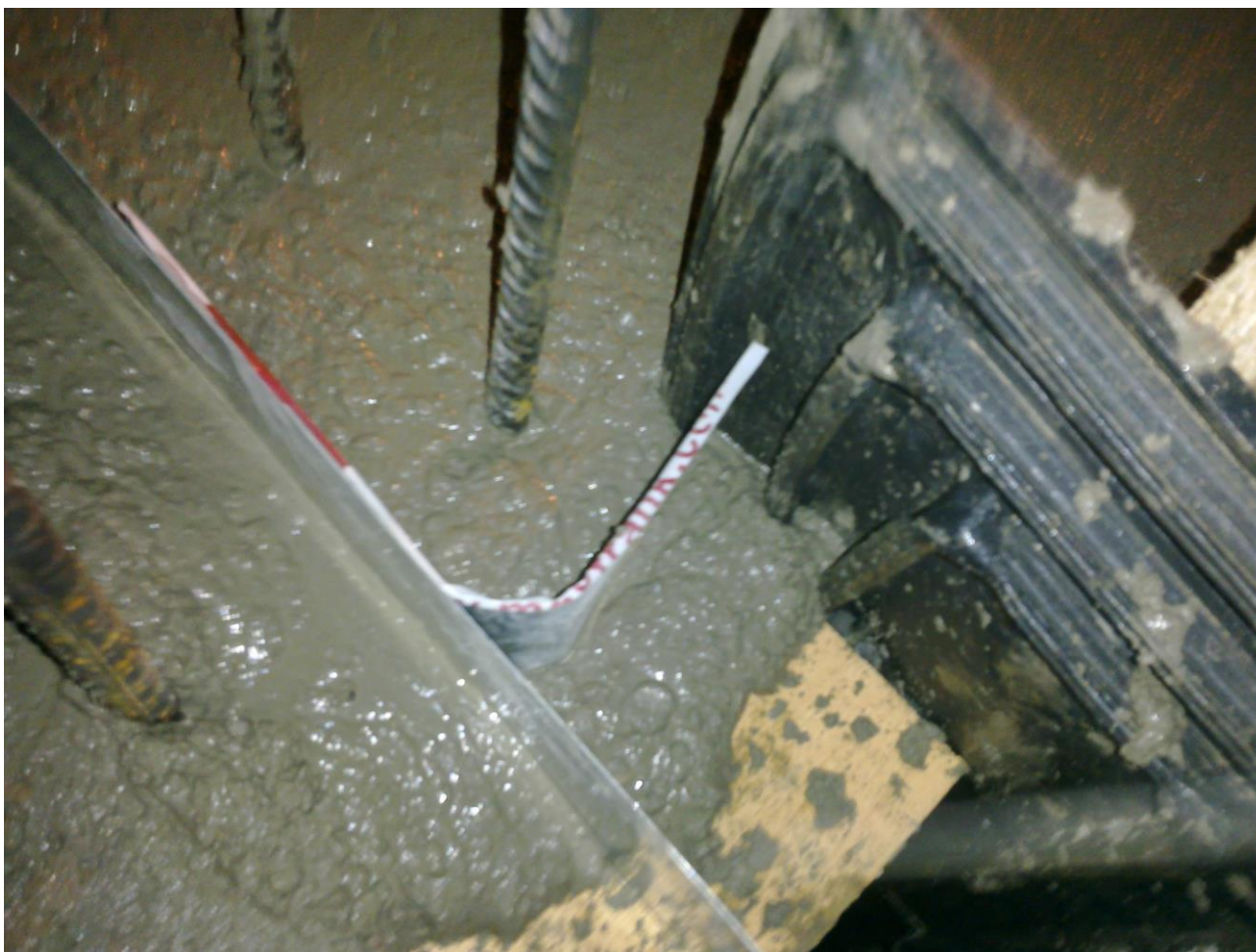
Fot. 15 Uszczelnienie przerwy roboczej na styku płyta- ściana oraz zakończenie zewn. taśmy z przerwy roboczej płyty
