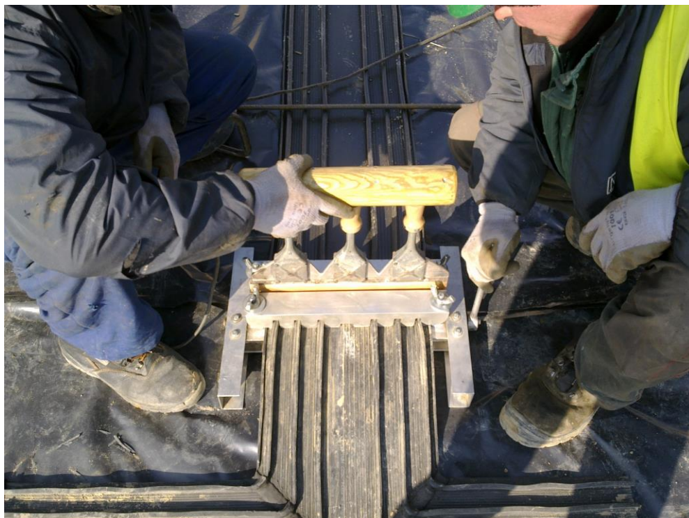
Fot. 14 Zgrzewanie zewnętrznej taśmy uszczelniającej
