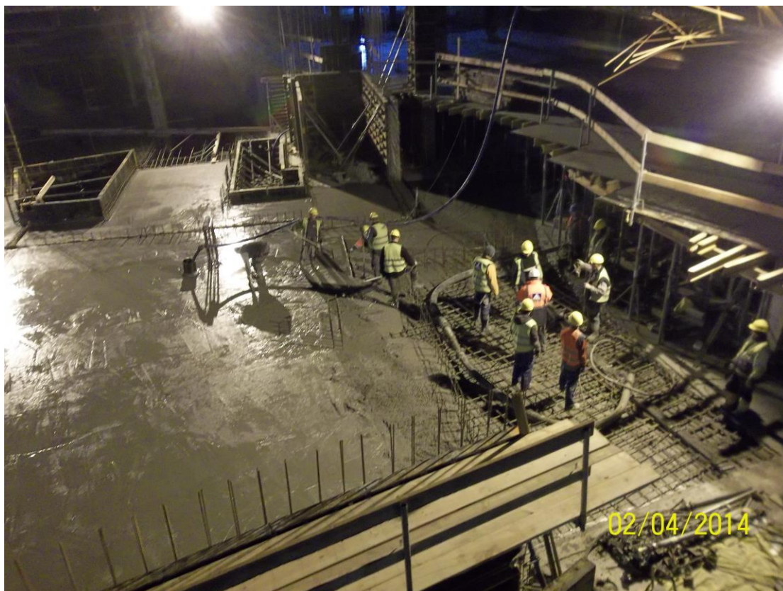
Fot. 3 Betonowanie płyty fundamentowej metodą podstropową
