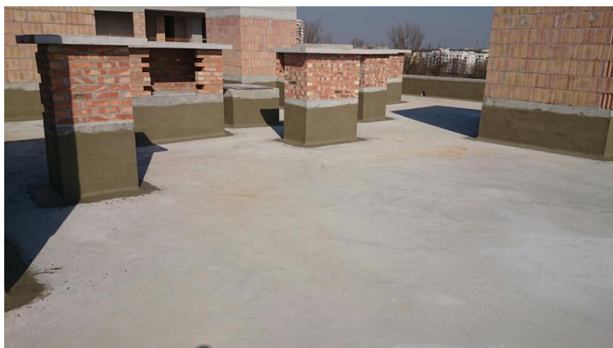
Fot. 20 Uszczelnienie stropodachu – zabezpieczenie przerw roboczych
