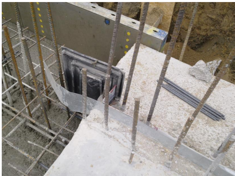
Fot. 16 Uszczelnienie przerwy roboczej na styku płyta- ściana oraz zakończenie zewn. taśmy z przerwy roboczej płyty
