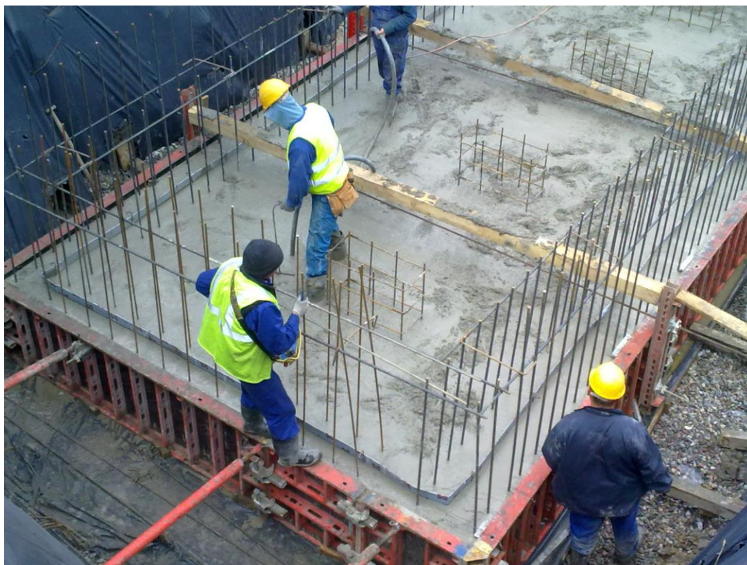
Fot. 17 Uszczelnienie przerwy roboczej na styku płyta
