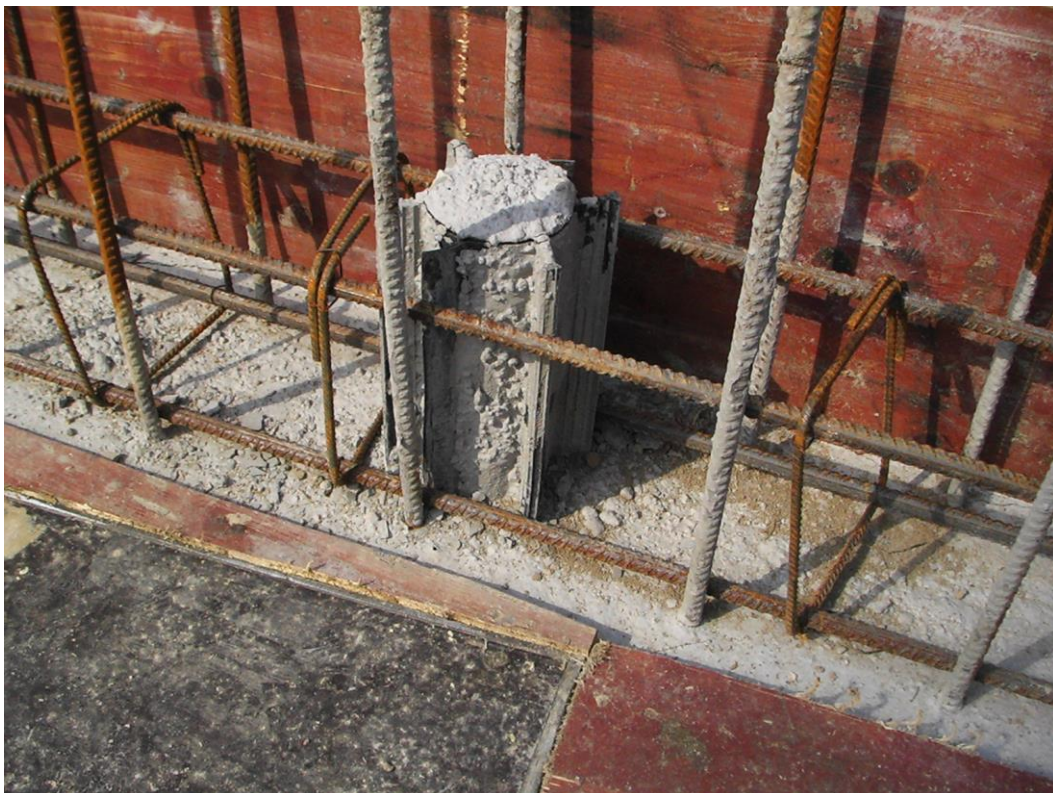
Fot. 12 Profil rysujący –uszczelniający Q88 w zewnętrznej ścianie fundamentowej
