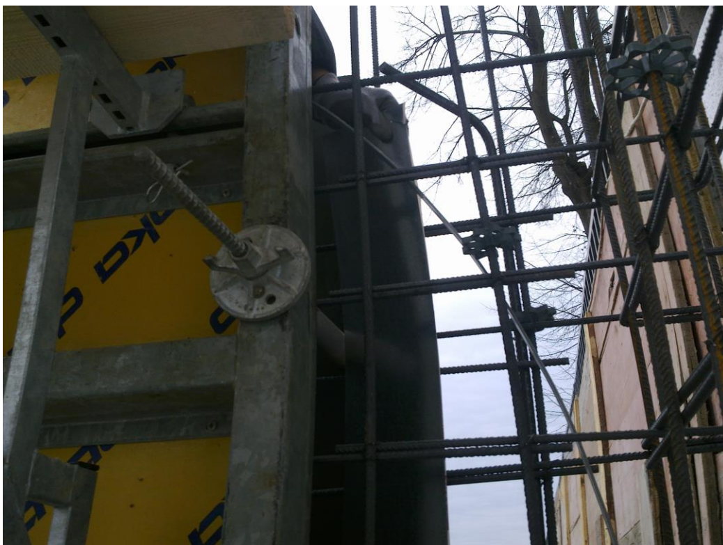
Fot. 19 Uszczelnienie przerwy roboczej zewnętrznej ściany fundamentowej
