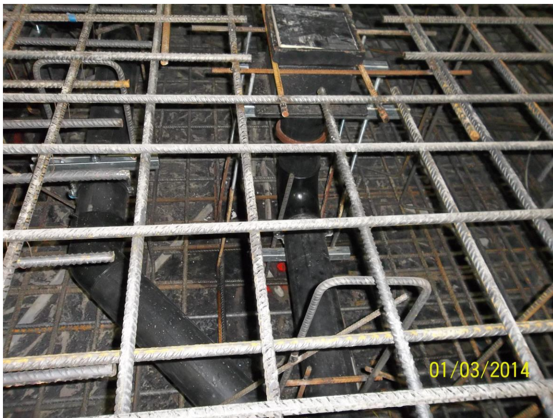
Fot. 4 Uszczelnienie przejścia instalacyjnego w płycie fundamentowej
