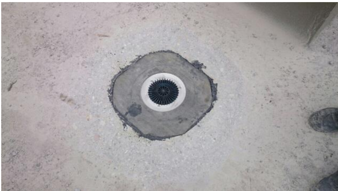
Fot. 23 Uszczelnienie wpustu systemu odwodnienia z kołnierzem termozgrzewalnym
