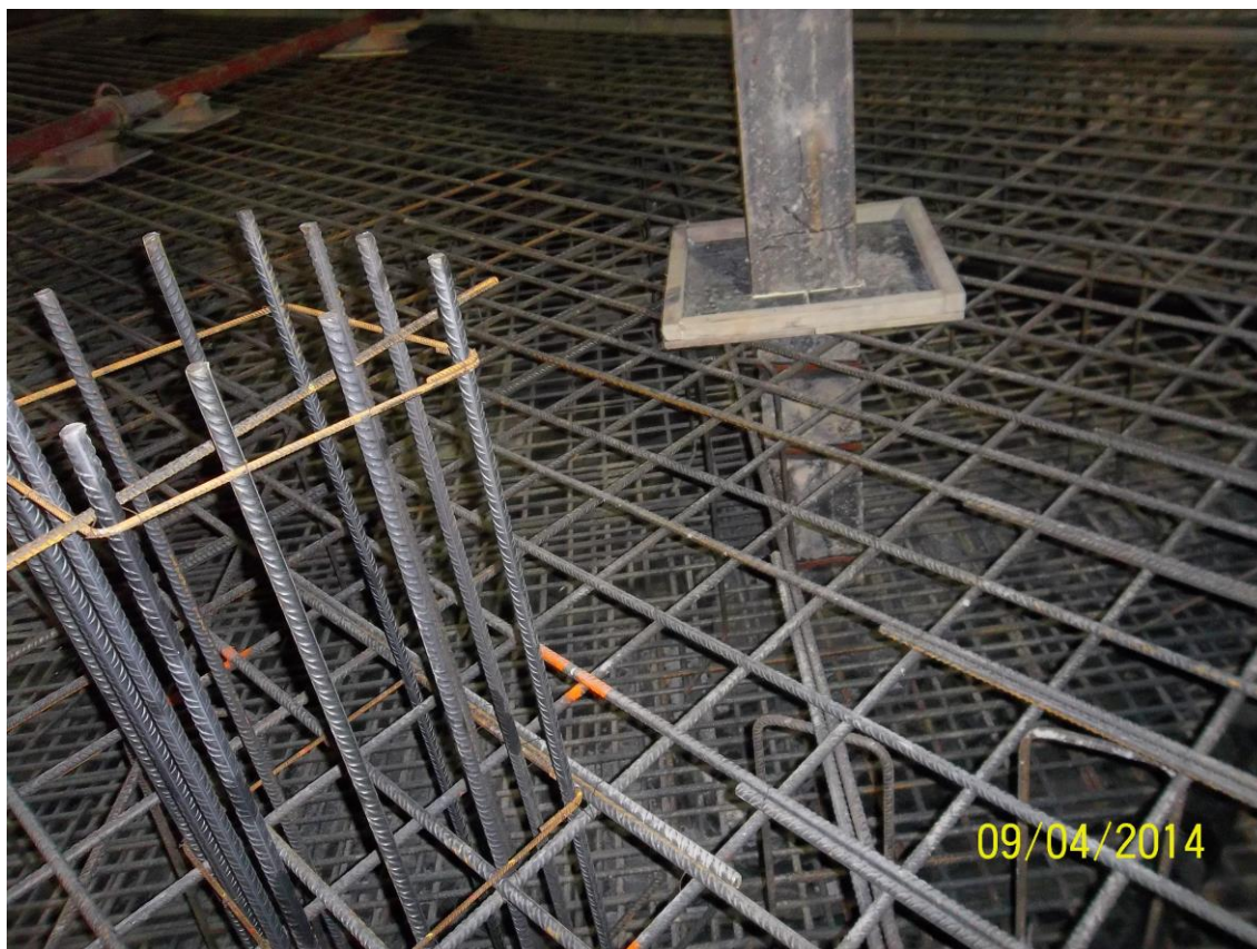
Fot. 2 Uszczelnienie słupa tymczasowego w płycie fundamentowej
