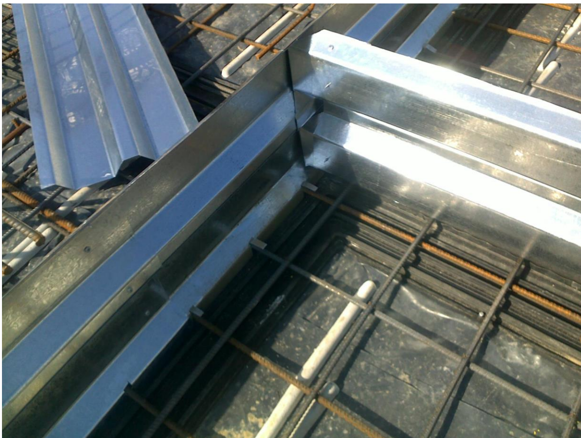
Fot. 7 Uszczelnienie przerwy roboczej/skurczowej w płycie fundamentowej
