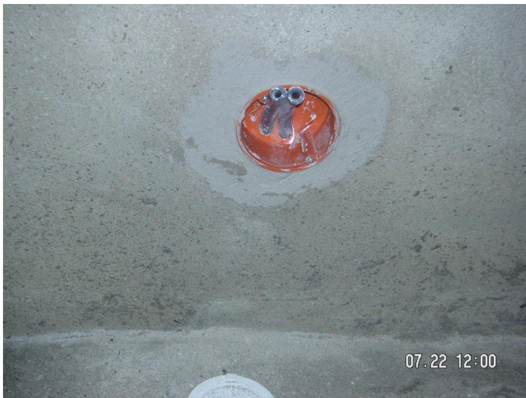
Fot. 13 Zakończenie węża iniekcyjnego INTEC PREMIUM
